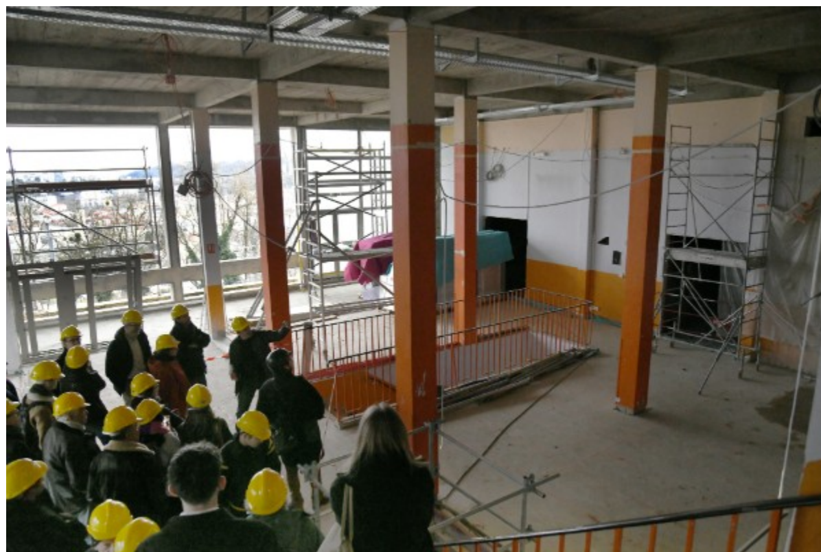
Visite de chantier de mise aux normes accessibilité de la MJC Lyon Duchère.
